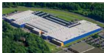
Hörmann KG Eckelhausen, Allemagne
