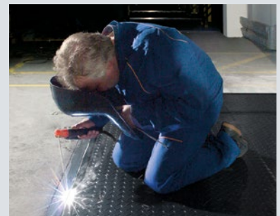
Soldar al premarco rebajado y listo.
