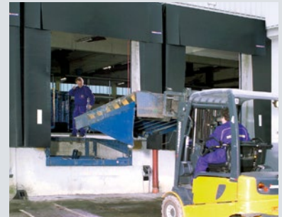
Desmontar la rampa niveladora antigua, en caso necesario adaptar la zanja (p. ej. con placas de montaje o consolas)
