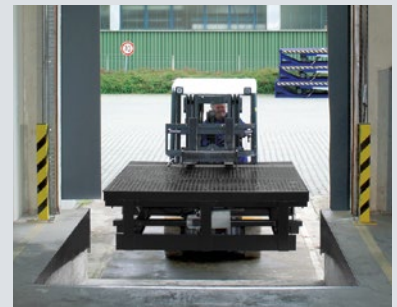
Colocar la rampa niveladora nueva
